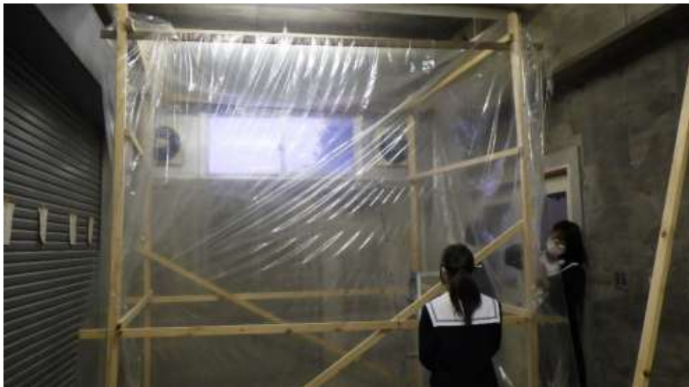
マッシュルーム栽培舎を建設
