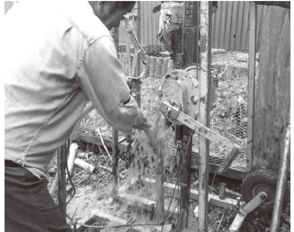
写真2 新しい井戸の採掘作業
