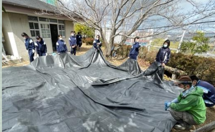
ビオトープ池のゴムシート張り
