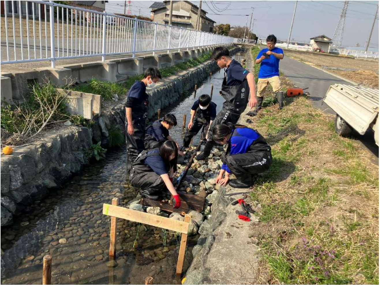
19. 階段設置のための施工 エビやドジョウが早速住み始めた
